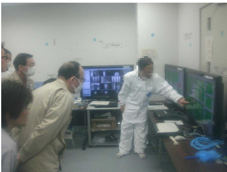
2号機原子炉圧力容器底部温度を1秒毎に更新表示する集中・遠隔監視システム
