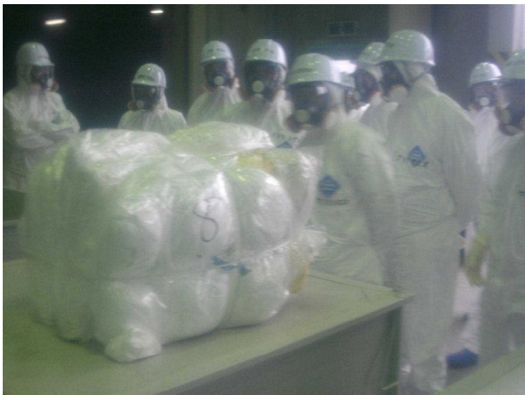
圧縮減容された使用済保護衣類等（5袋分）、保管用の鋼製コンテナ（約90袋程度が入る）
