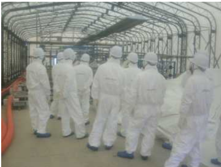
淡水化装置（RO）を覆う保温ハウス（暖房あり） 〔水処理施設のジャバラハウス内〕
