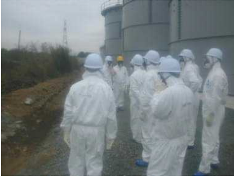
左側の水路の手前に土嚢による 堰を構築 〔RO濃縮水貯水タンクエリア〕
