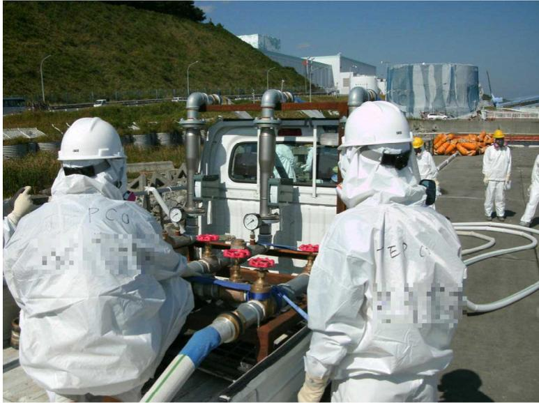
炉注水設備復旧訓練（海水注水量の調整作業）
