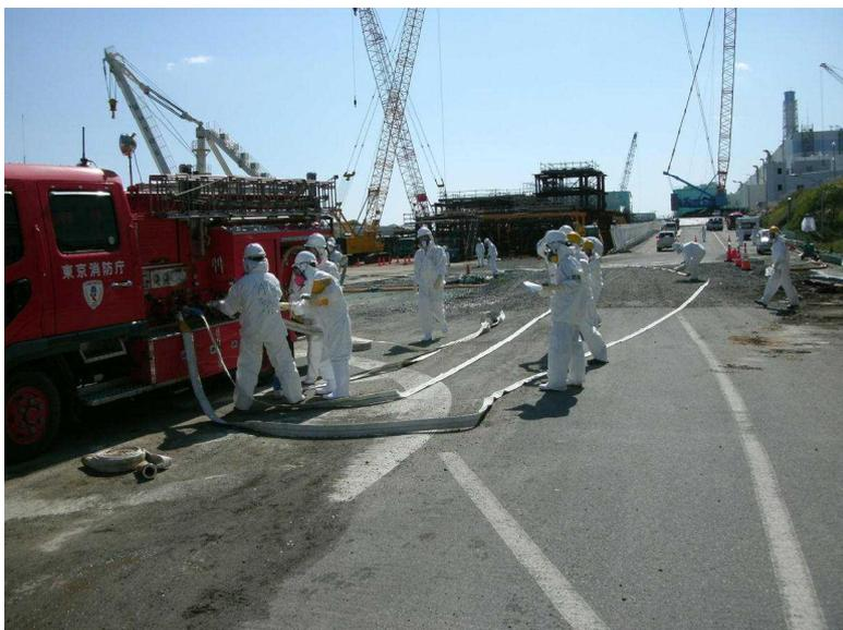
炉注水設備復旧訓練 (消防ポンプ車との送水ホースの連結作業)
