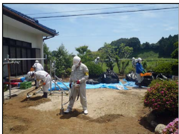
家屋除染作業 (H24当時)
