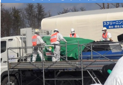
보관소에 제거 토양 수락 확인 작업
