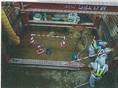
写真① 発進立坑部 ライナー組立・掘削工
