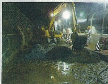
写真② 南護岸部 地盤改良工
