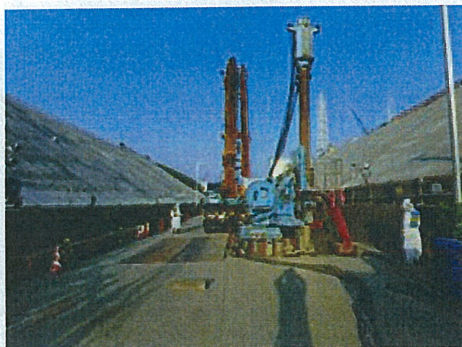
写真② 地下水BP→大熊通りの接続柵部 立坑構築
