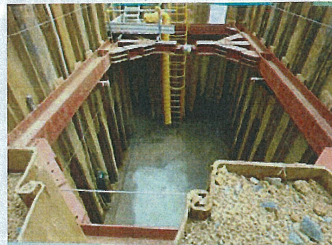
写真④ 大熊通り接続柵部 発進立坑構築
