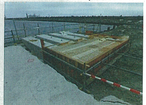
写真③ 放流口部 放流口開渠基礎構築
