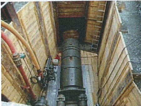
写真① 地下水BPエリア(推進発進立坑・推進機搬入)
