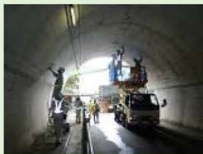
(トンネル点検)
