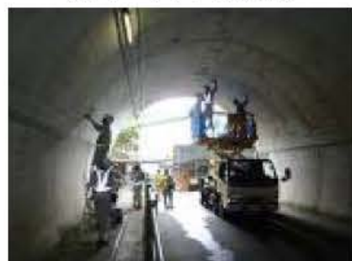
(トンネル点検)
