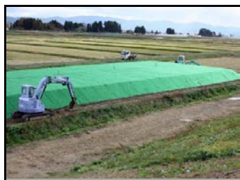
仮置場 設置工
