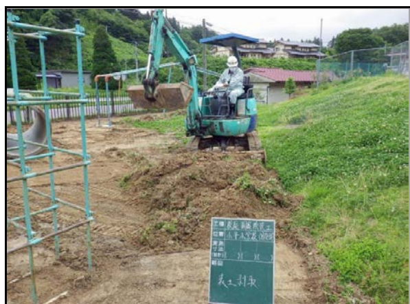
校庭除染工事表土剥取
