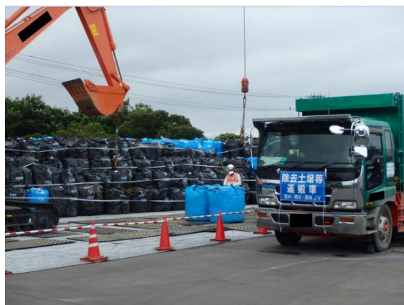
除去土壌の積下ろし作業
