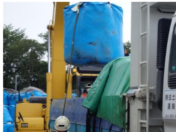
除去土壌の積み込み作業
