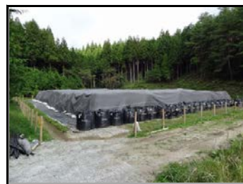
キャッピング完了後
