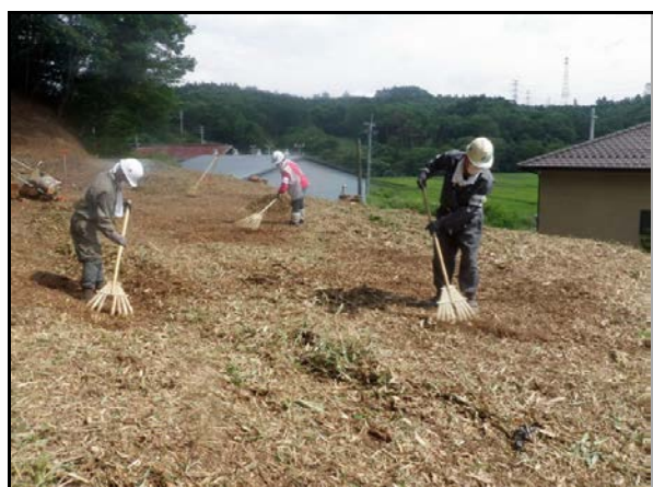
森林(生活圏)の除染状況(堆積物除去)
