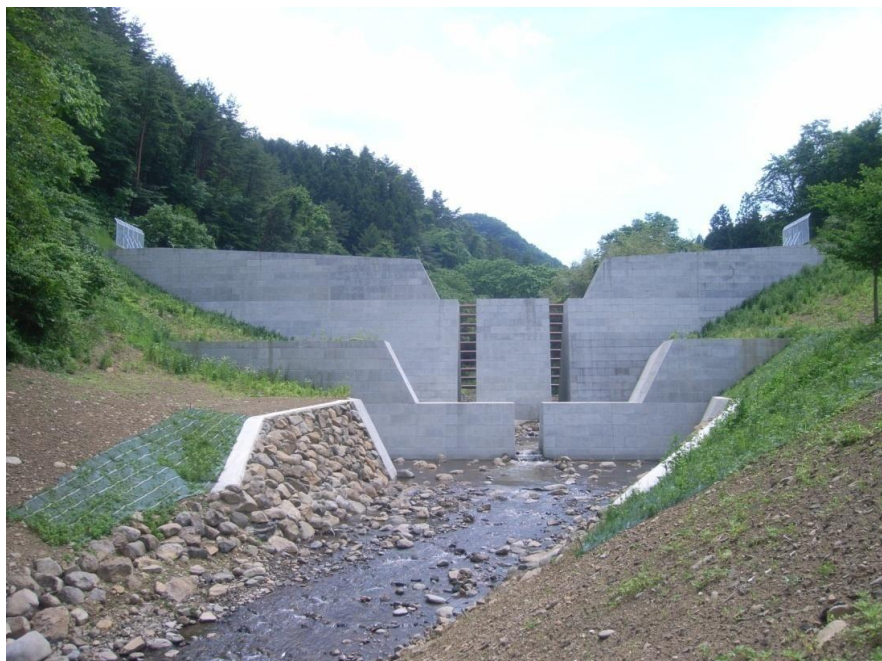
火山砂防 藤入川(福島市松川町水原地内)
