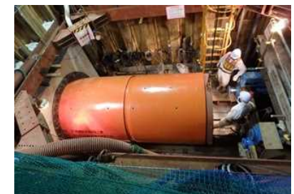
<写真② 推進機投入・接続>
