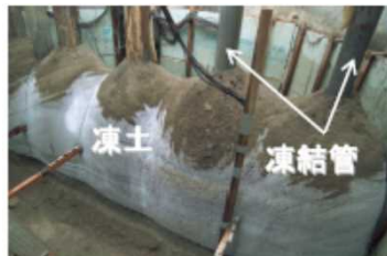
凍結管周囲の土が凍り始めます
