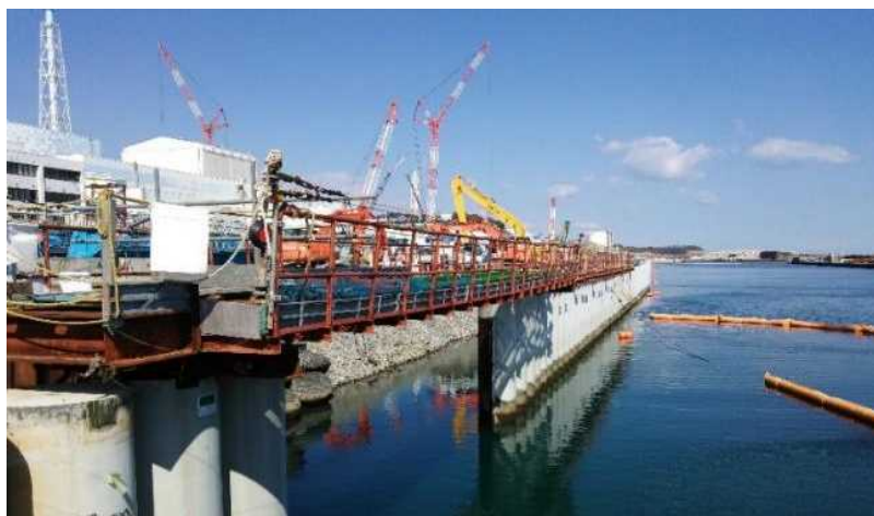
<写真①：海側遮水壁閉合箇所：鋼管矢板9本分（延長約10m）>
