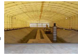
覆土式一時保管施設第3槽全景
