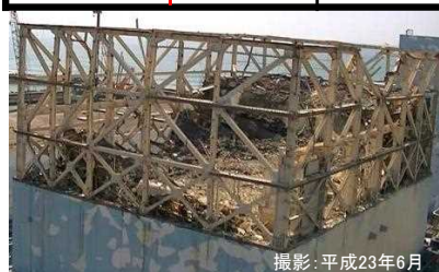
建屋カバー設置前の状況 撮影:平成23年6月
