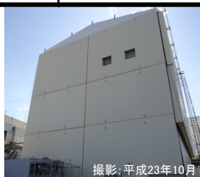
建屋カバーの設置状況 撮影:平成23年10月
