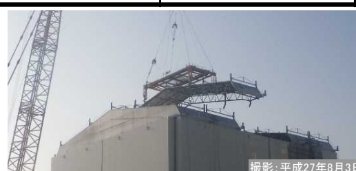
屋根パネルの取り外し(再開時、2枚目) 撮影:平成27年8月3日
