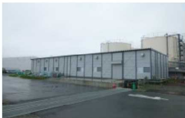
①移送設備建屋
