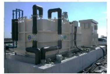
②地下水ドレン中継タンク（3基）
