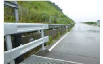
③排水配管
