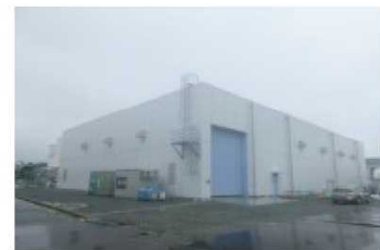
③サブドレン浄化設備建屋
