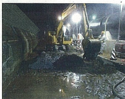
写真② 南護岸部 地盤改良工
