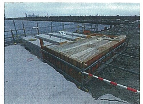
写真③ 放流口部 放流口開渠基礎構築
