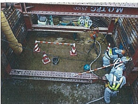
写真① 発進立坑部 ライナー組立・掘削工 東京電力
