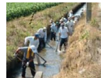
水路の泥上げ
