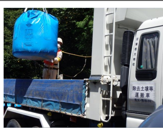
除去土壌の積み込み作業
