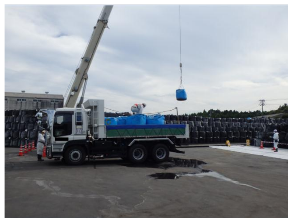
除去土壌の積下ろし作業
