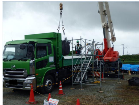
除去土壌の積み込み作業
