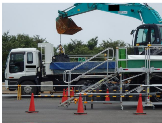
除去土壌の積み替え作業
