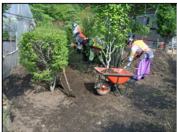
汚染土壌剥ぎ取り作業
