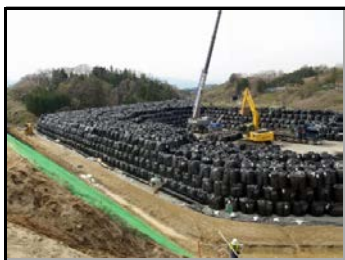
仮置場 搬入中
