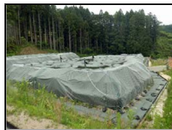
仮置場 搬入済み
