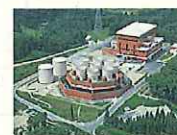
柳津西山地熱発電所
