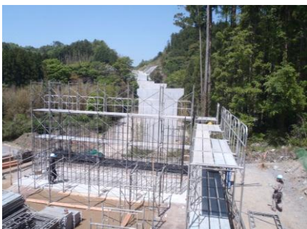
(仁井田川橋梁工事 A2橋台実施状況) (農村整備部)
