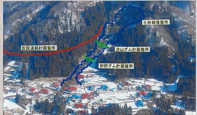
身近で起こる山地災害 平成19年2月7日土砂災害発生（金山町小栗山地区）
