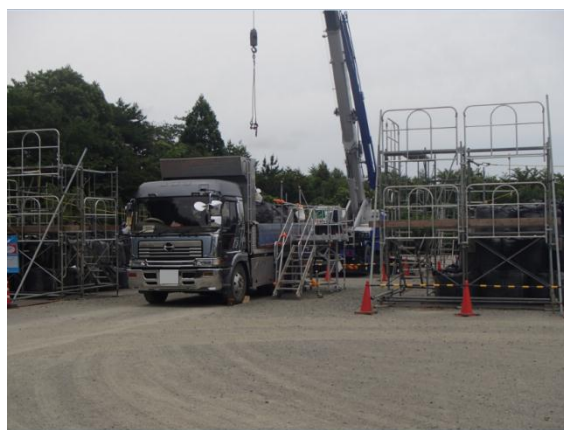
除去土壌の積下ろし作業
