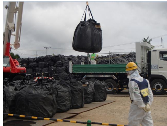
除去土壌の積み込み作業
