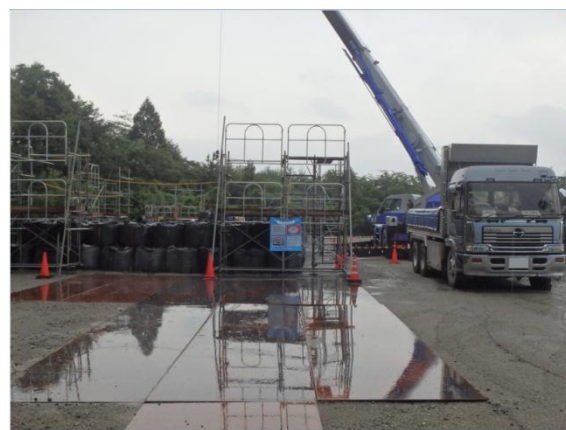
除去土壌の積下ろし作業
