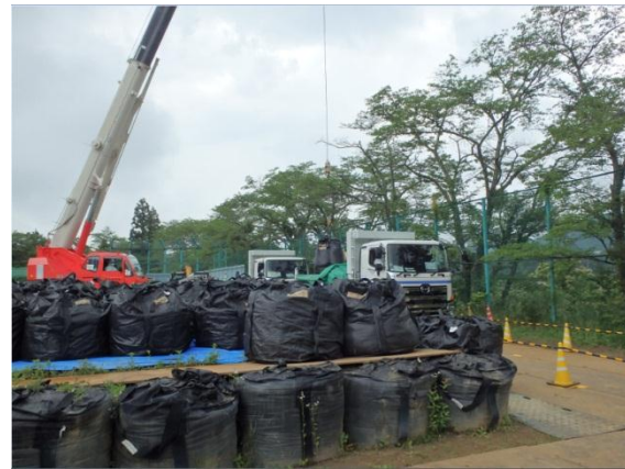
除去土壌の積み込み作業
