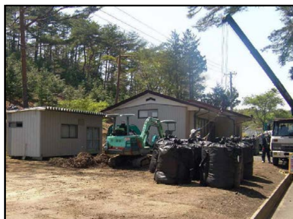
公共施設の除染状況(フレコン運搬)
