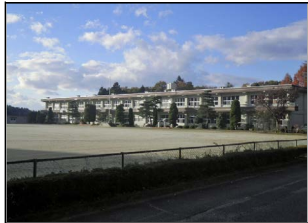
除染現場 (山白石小学校)
