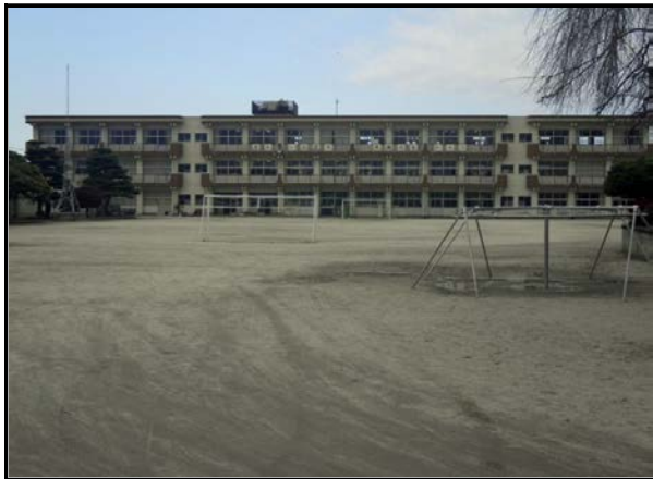
除染現場 (浅川小学校)
