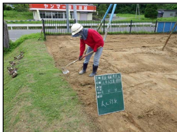
校庭除染工事表土剥取
