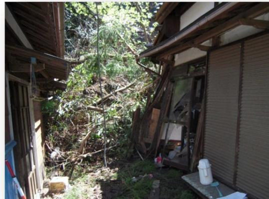
図7 H25.4豪雨による崩落
