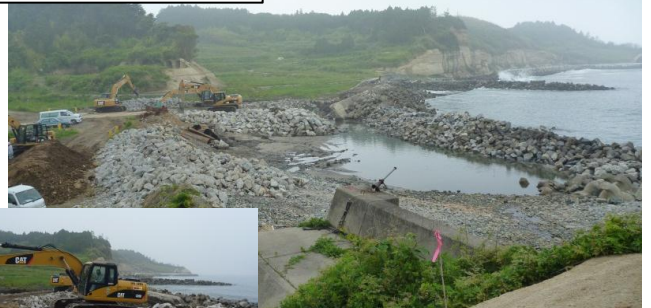
(波を抑えるための石を設置している状況)
