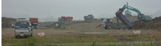
(道路の盛土に使う土砂を搬入している状況)
