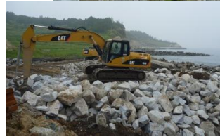
(波を抑えるための石を設置している状況)
