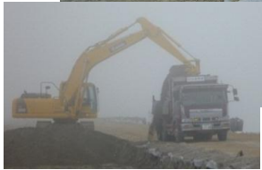
(新たな堤防をつくるため地盤を掘っている状況)
