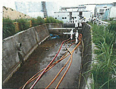
K-4-2側溝 水回収後
