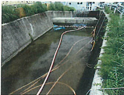
K-4-2側溝 水回収前
