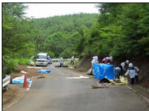
道路除染状況
