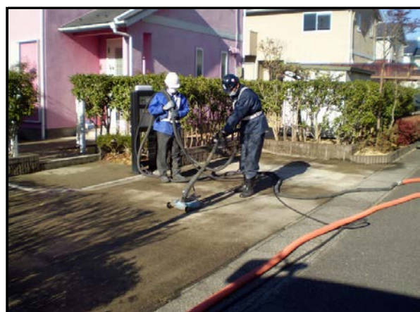
コンクリート洗浄作業
