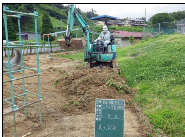
校庭除染工事表土剥取
