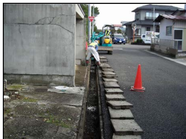
仁井田地区内側溝除染作業
