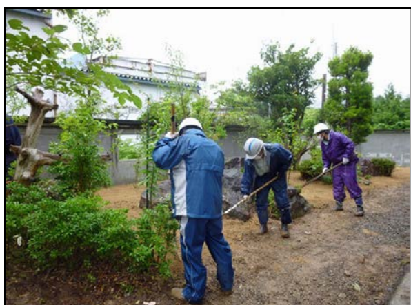
住宅除染実施状況
