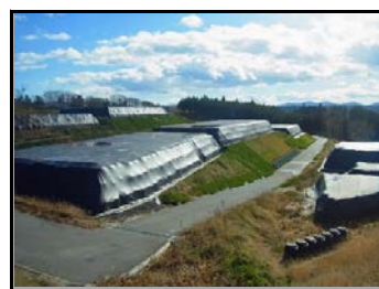
長屋地区仮置場
