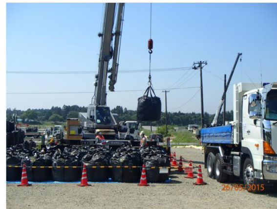
除去土壌の積み込み作業
