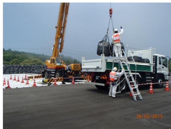
除去土壌の積下ろし作業
