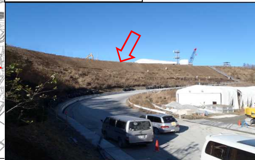
<35m盤1～4号法面表土剥ぎ施工状況>
