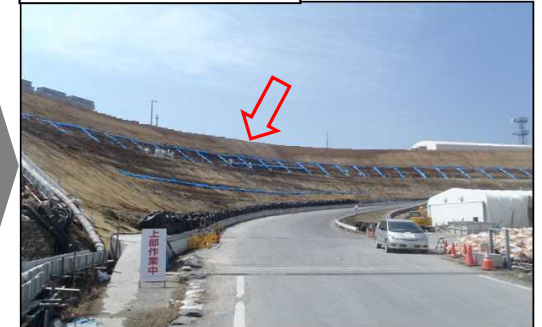
<35m盤1～4号法面表土剥ぎ施工状況>
