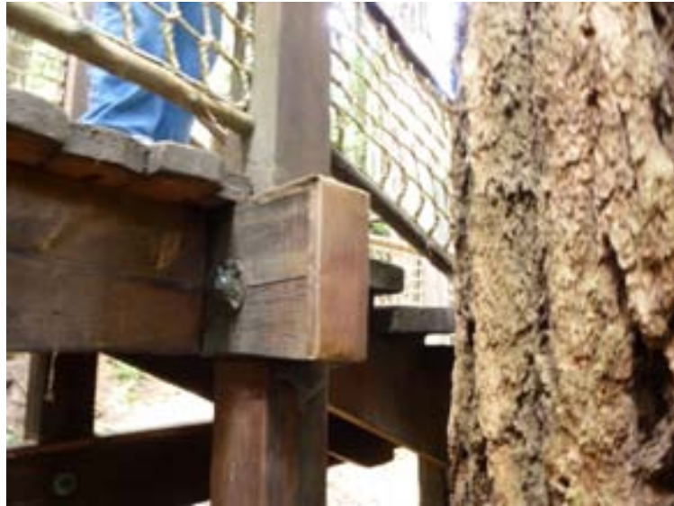
図 2.5.16 小口に金属製カバーを設置する例
