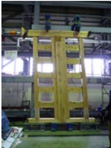
写真1 高倍率耐力壁の実験状況
