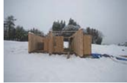
縦ログパネル建て方風景
