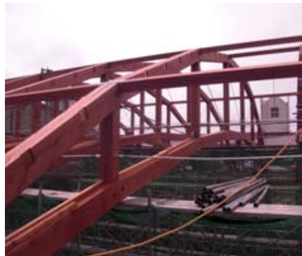
写真2 福島県産杉製材を使用した体育館のトラスフレーム
