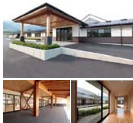
写真2 上:外観(玄関)、 左下:テラス 右下:廊下
