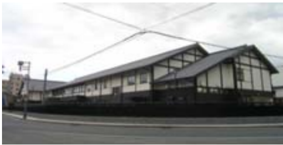
北西側より校舎を見る
