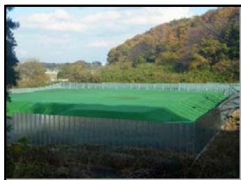
太田川仮置場
