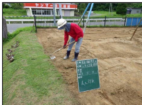
校庭除染工事表土剥取
