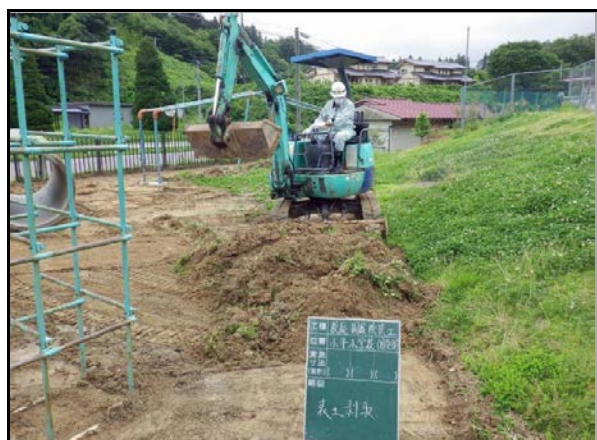
校庭除染工事表土剥取
