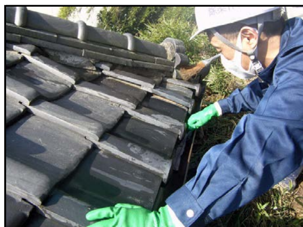
屋根拭き取り状況
