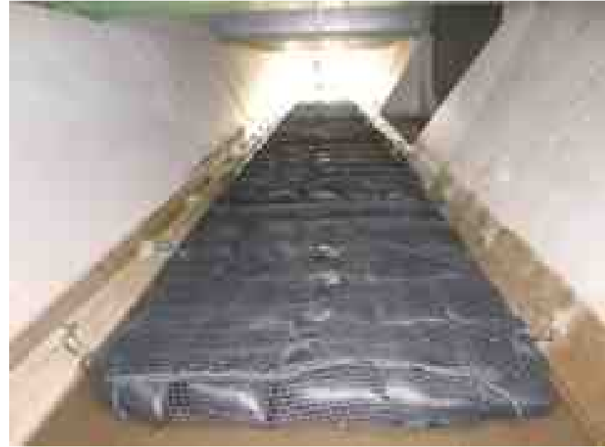
BC排水路暗渠部【写真②】
