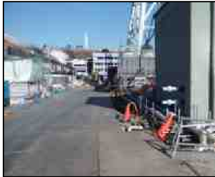
現場状況写真
