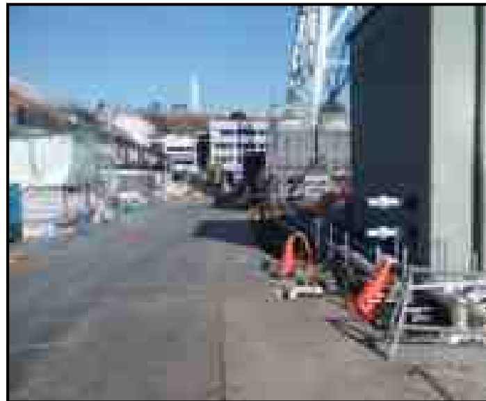
現場状況写真
