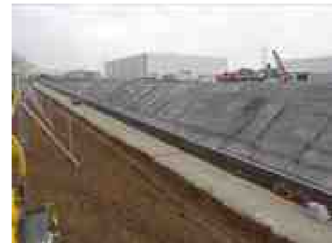
現場状況写真（写真②）
