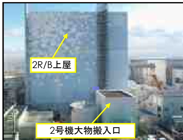
現場状況写真
