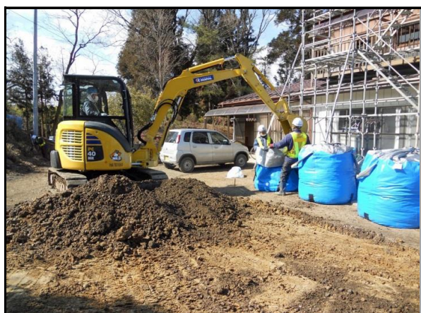
地表面の除染及び汚染土の袋詰め
