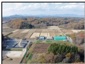
除去土壌の格納状況
