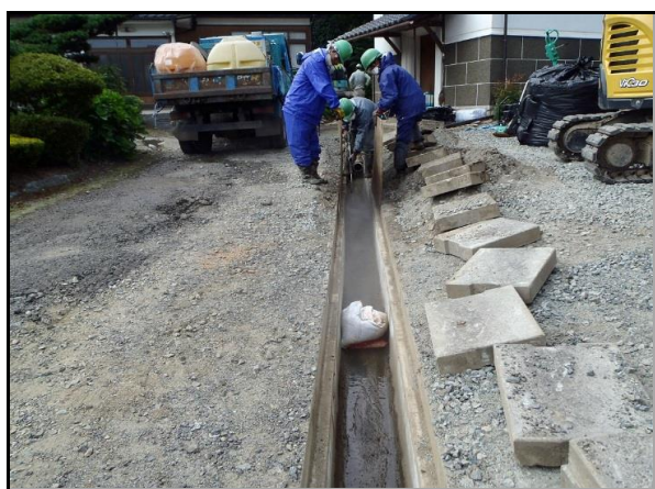
側溝の高圧洗浄
