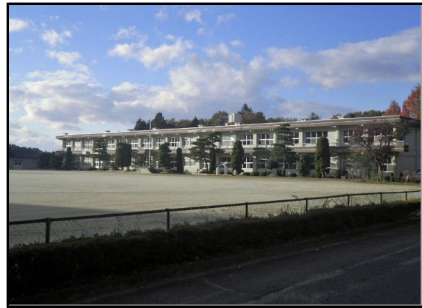
除染現場 (山白石小学校)
