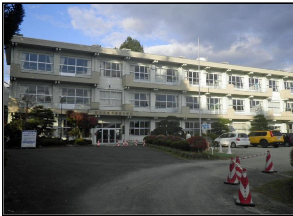
除染現場 (里白石小学校)
