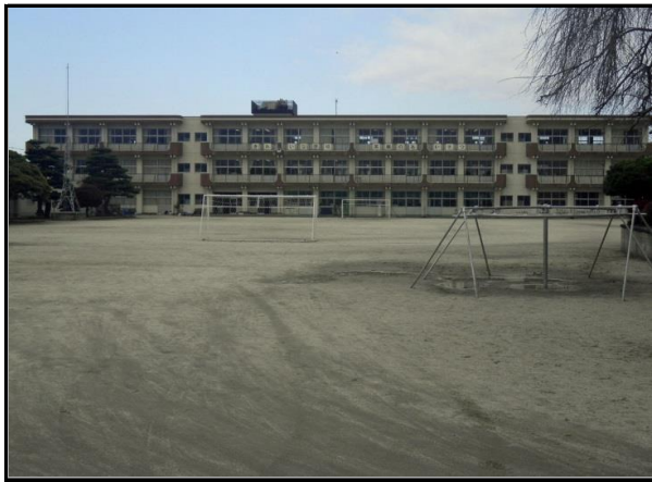
除染現場 (浅川小学校)
