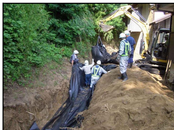
フレコン埋設作業
