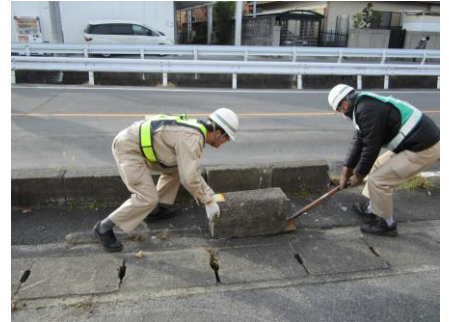
応急補修作業
