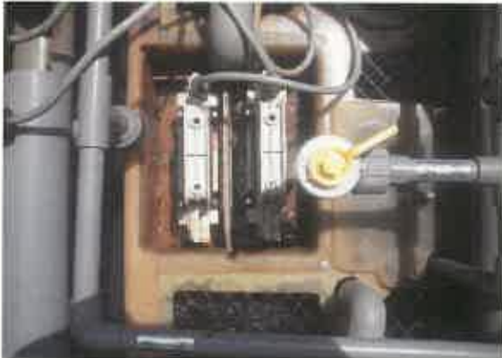
写真 1 鉄電極板の設置状況
